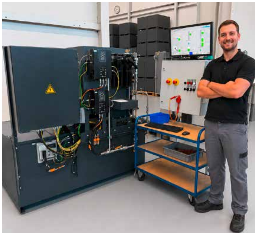
Spezieller Bereich: Die Hochspannungs- prüfung von Kühlmittelanlagen.
